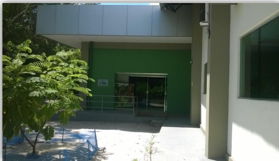
Figura 10. Prédio do Centro de Estudos dos Quelônios da Amazônia (CEQUA).
